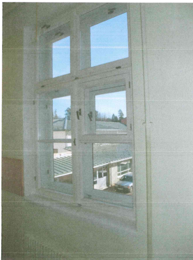
42. attēls. Jaunais logs L-B238 B korpusa 2.stāvā pagalma pusē. Skats no iekštelpas.
