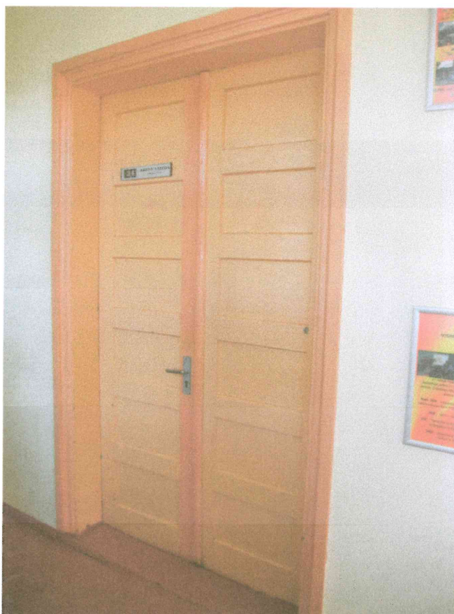
36. attēls. B korpusa divviru pildīņu durvis D-B215 2.stāvā.
