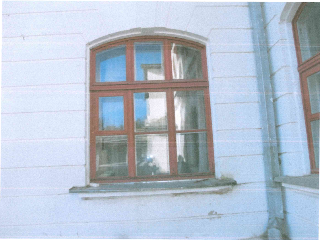
39. attēls. 1. stāva logs L-A142 A korpusa pagalma fasādē.
