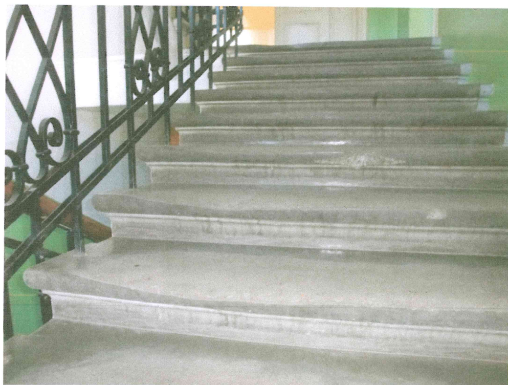
54. attēls. Galveno kāpņu pakāpieni izdiluši kāpiena vidusdaļā..
