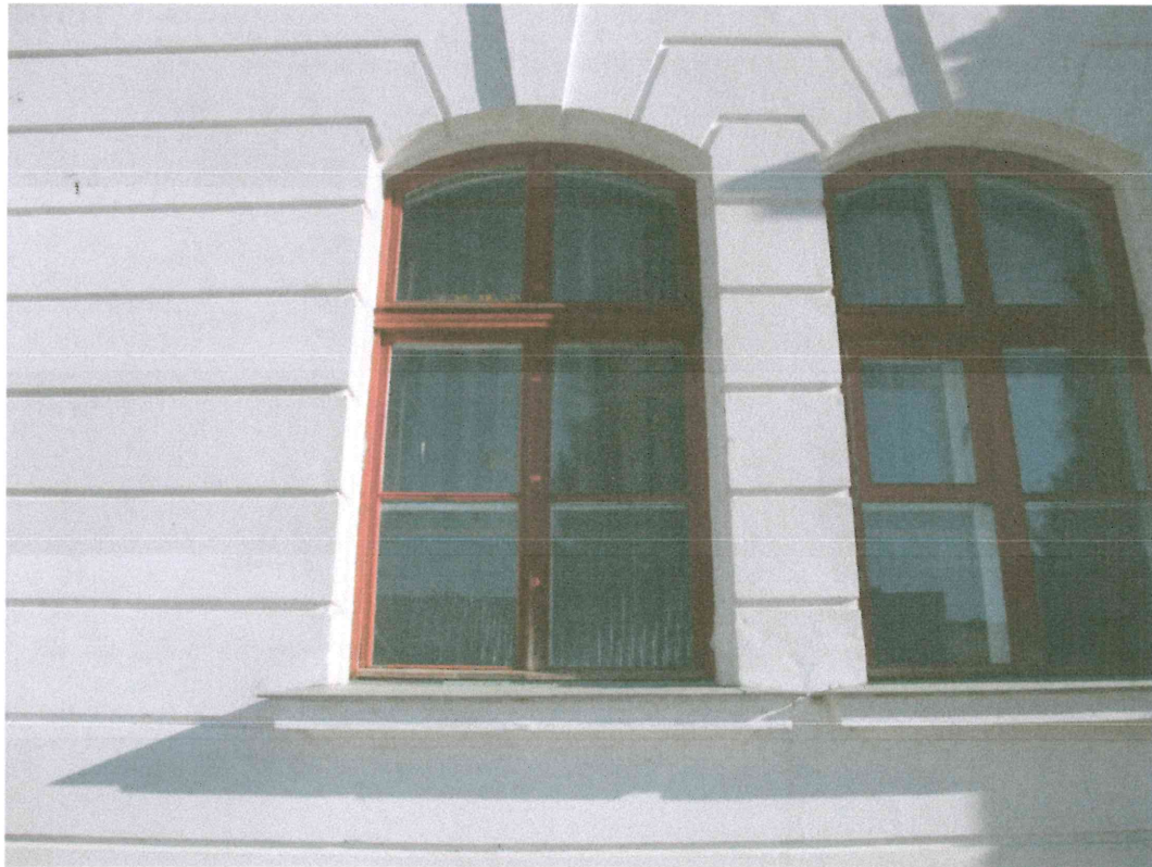
37. attēls. 1.stāva logi L-A107, L-A108 A korpusa ielas fasādē.
