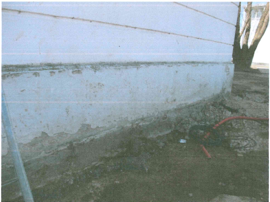
10.attēls. Cokola fragments B korpusa austrumu fasādē.
