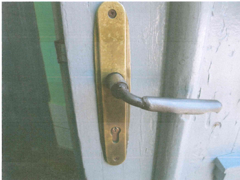
18.attēls. Durvīm D-A101 saglabājusies sākotnējā furnitūra- rokturis un atslēgas vairogs.
