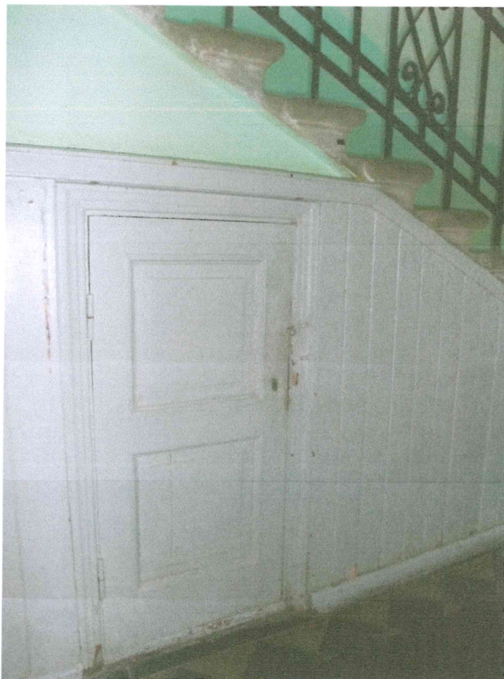
33. attēls. A korpusa 1. stāva pildīņu durvis D- A118 uz patrepi.
