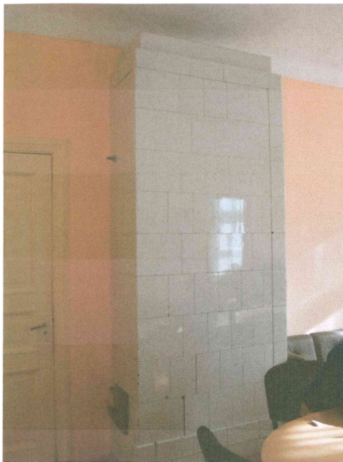
57. attēls. Sākotnējās podiņu krāsns saglabājusies labā stāvoklī A korpusa 1.stāvā (telpa nr.3).
