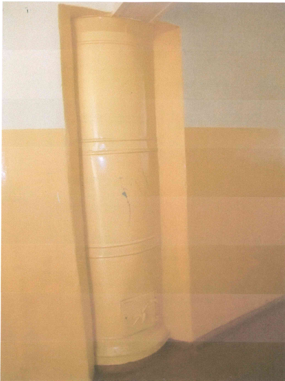
59. attēls. Saglabājusies apaļā skārda krāsns B korpusa 2.stāvā (telpa 56).
