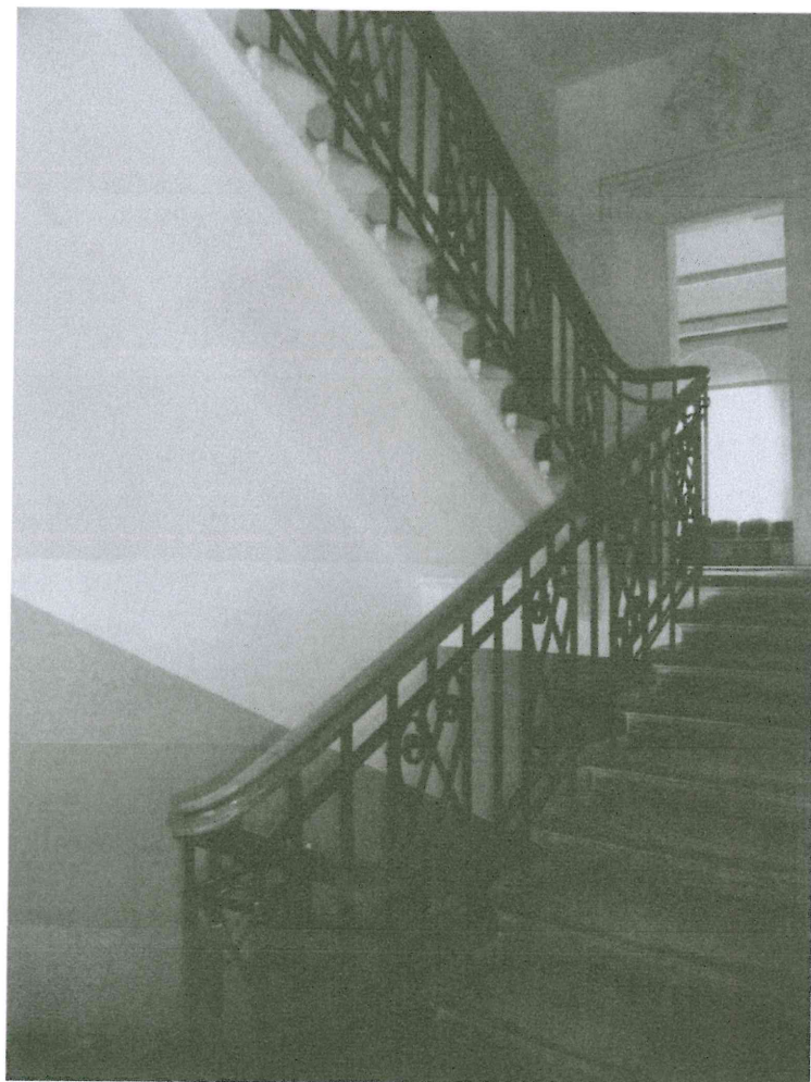
53. attēls. Saglabājušās sākotnējās betona kāpnes ar oriģinālajām metāla margām A korpusā.
