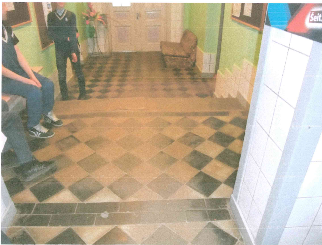
48. attēls. Sākotnējais grīdas flīzējums 1.stāva gaiteņa daļa pa kreisi no galvenās ieejas (telpa nr.21).
