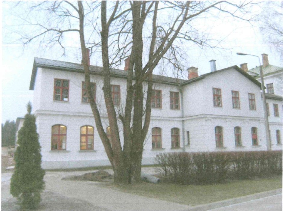
9.attēls. Darbņīcu (B) korpusa ziemeļu fasāde.
