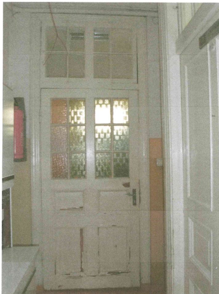
31. attēls. A korpusa 1. stāva stiklotas iekšdurvis D-A108 ar virslogu.
