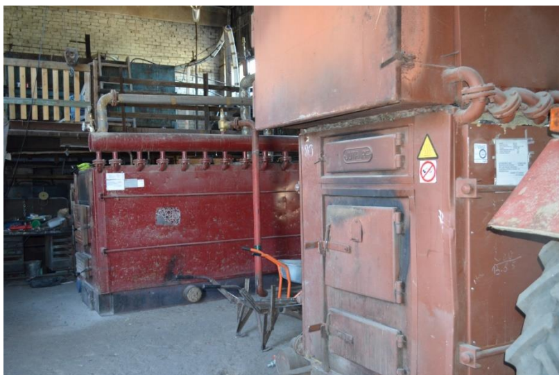
3.4.1.att. Lejasciema katlu mājā uzstādītie malkas apkures katli ar jaudu 1 un 1,5 MW
