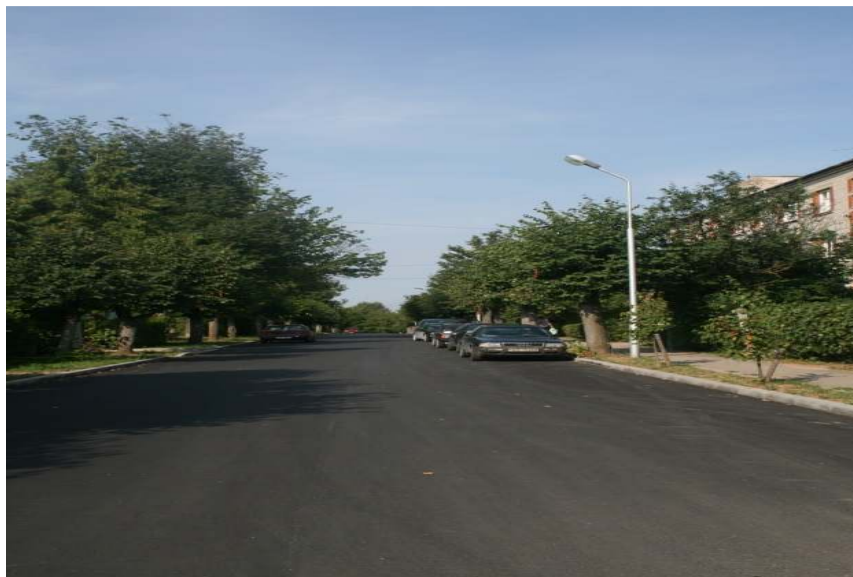
24.attēls. Gulbenes pilsētas ielu seguma rekonstrukcija 2.kārta
