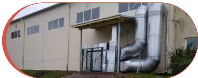
Ventilācijas sistēmas izbūve Tirzas pamatskolā
