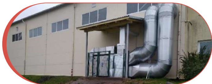
Ventilācijas sistēmas izbūve Tirzas pamatskolā
