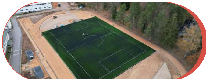
Sporta centra stadiona pārbūve
