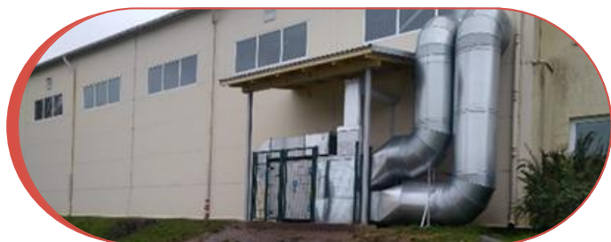
Ventilācijas sistēmas izbūve Tirzas pamatskolā
