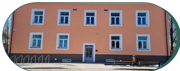
Stradu pagasta "Stāķi 11" ēkas pārbūve
